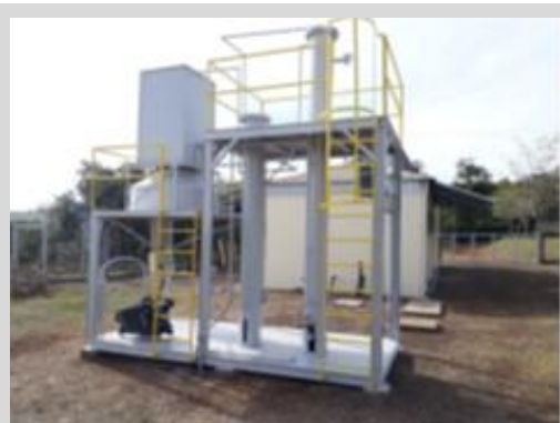
Figura 9 - Sistema de tratamento de biogás - Condomínio de Agroenergia para Agricultura Familiar – Sanga Ajuricaba.
